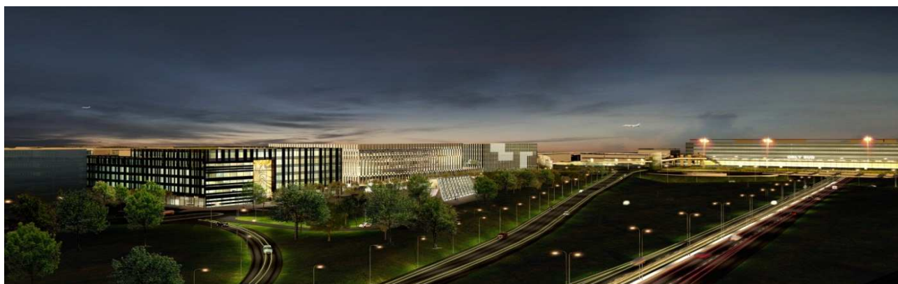
Vue d'ensemble de Cœur d'Orly, avec l'immeuble Askia au premier plan ©ArteFactoryLab
